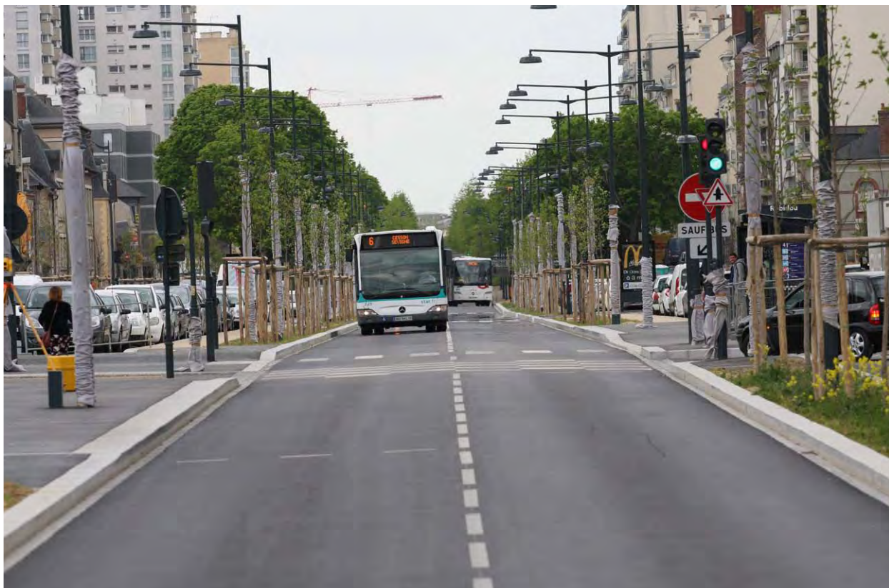
La fin des travaux sur l'ensemble de la section Lenoir-Beaulieu est prévue pour l'automne 2013.
