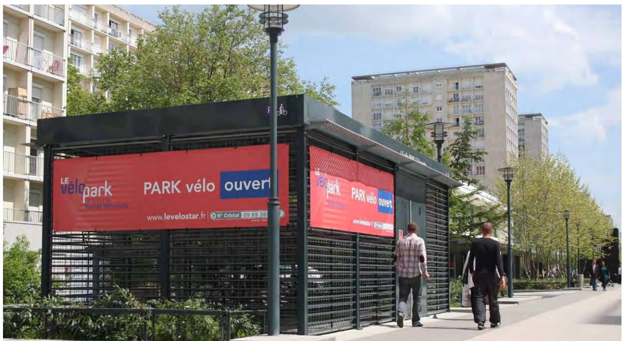
Comme le parking à vélos de Kennedy, sept vélos park seront prochainement mis à disposition des usagers. Ils fonctionnent comme un parc relais, mais sont réservés aux vélos.
